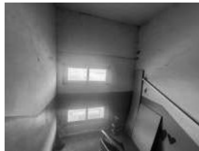
2.stāva kāpņu telpa
