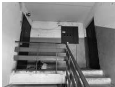
2.stāva kāpņu telpa
